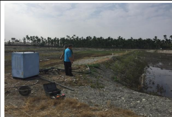
B3 池打樁做磅浦之懸吊
